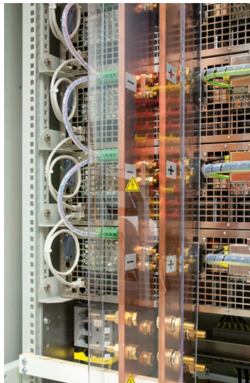
DC-Anschluß / DC bus terminal
